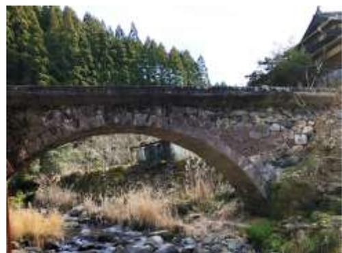
河俣地区には河俣川の支流の美生川があり、4つのめがね橋が架かっています。その一つに蓼原橋があります。この橋は東陽地区の橋の中では珍しく扇形に壁石(側面の石)が積んであります。これは通潤橋の壁石の積み方と同じです。しかし橋の方は野面積みで、これは上部を平らにした跡か、洪水で流された部分を修復した跡かもしれません。
