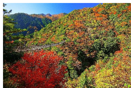
梅ノ木轟公園吊り橋
