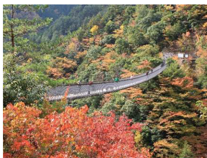
▲梅の木轟公園吊橋
