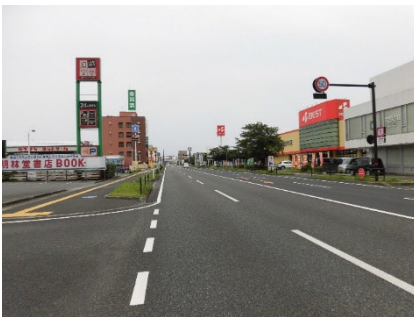
▲国道3号（電線地中化）
