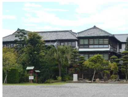
▲日奈久温泉街の木造建造物
