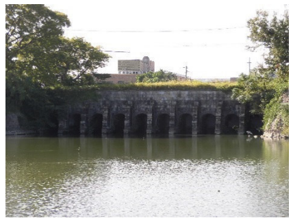
▲旧郡築新地甲号樋門
