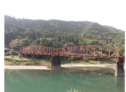
▲球磨川第一橋梁（JR肥薩線）
