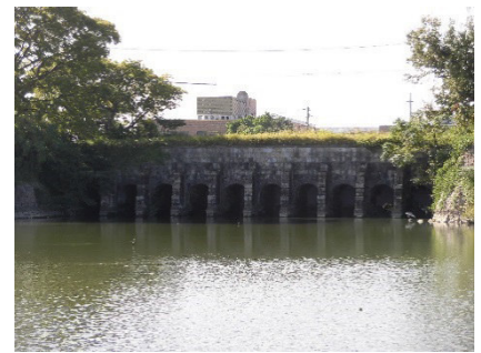
▲旧郡築新地甲号樋門
