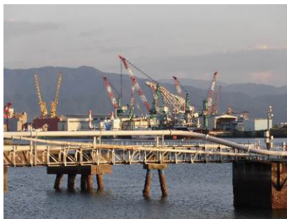
▲工場地のクレーン群
