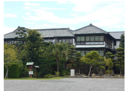
▲日奈久温泉街の木造建造物
