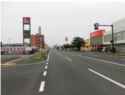
▲国道3号（電線地中化）
