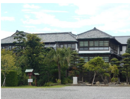
▲日奈久温泉街の木造建造物
