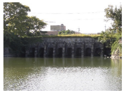
▲旧郡築新地甲号樋門
