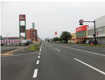
▲国道3号（電線地中化）
