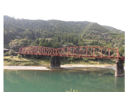
▲球磨川第一橋梁
