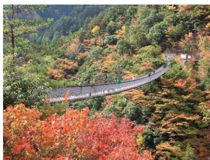
▲梅の木轟公園吊橋
