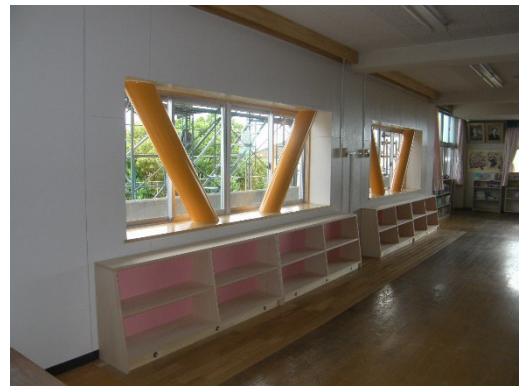
図 4.3.1 耐震改修状況
