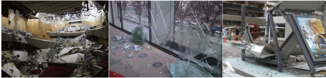
図 4.5.1 非構造部材の被害【天井・窓ガラス・外壁】 (写真：(左) 国土交通省、(中、右) 仙台市)
