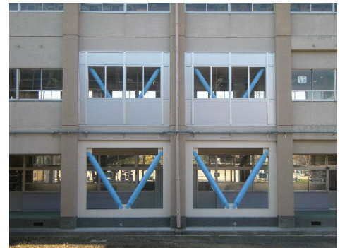
図 4.2.1 学校の耐震改修状況
