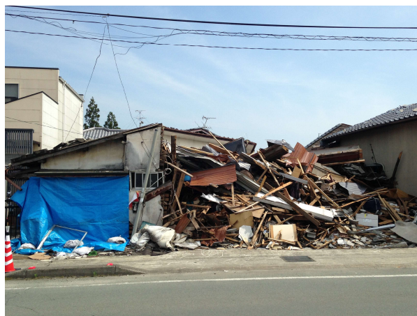
図 1.1.1 熊本地震の状況
