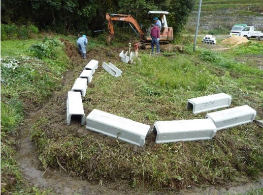
農業用水路の整備
