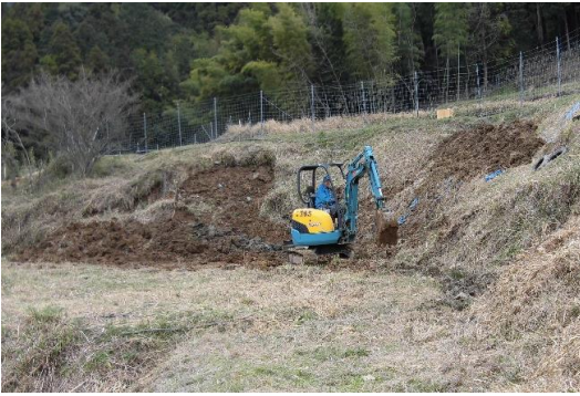
法面崩壊の修復
