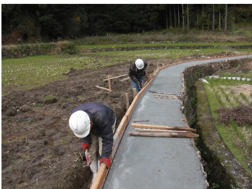
農道のコンクリート舗装
