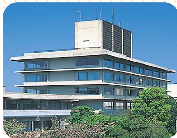
八代市役所本庁舎
