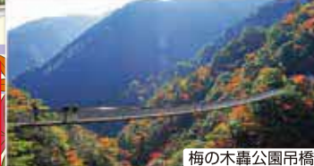
梅の木轟公園吊橋
