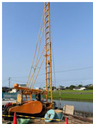
井戸の掘り直し作業の様子
