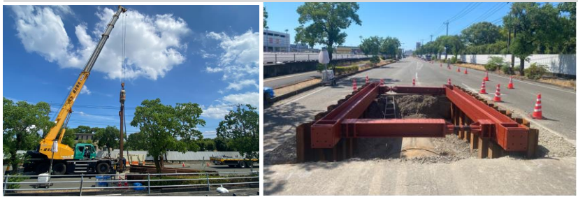
鋼矢板打設状況
