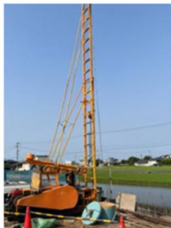
井戸の掘り直し作業の様子
