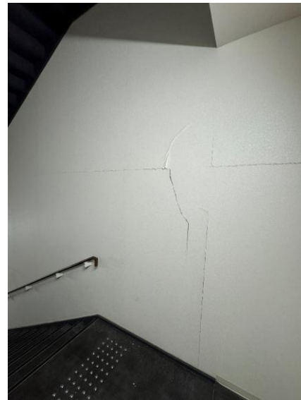
3階西側階段室
