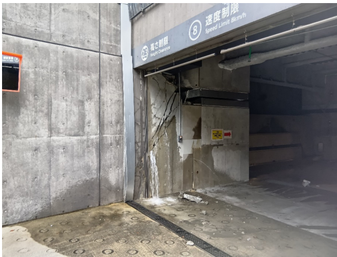
地下駐車場出入口
