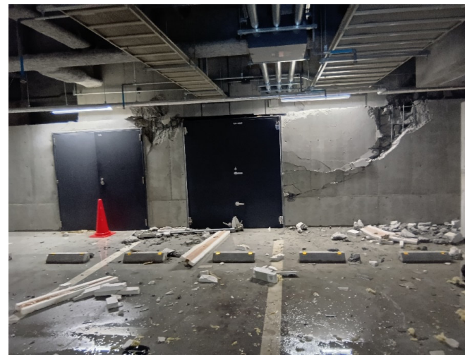
地下駐車場西側壁
