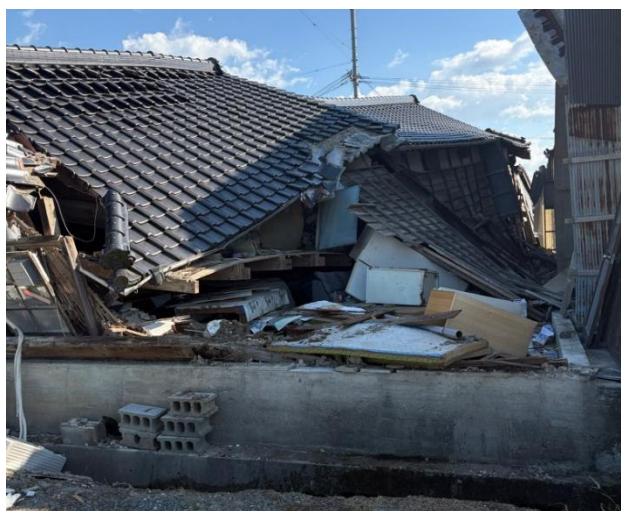
織機小屋の倒壊
