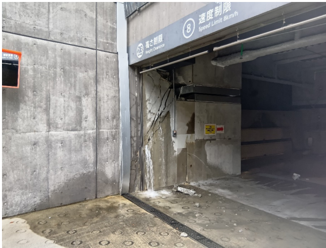
地下駐車場出入口
