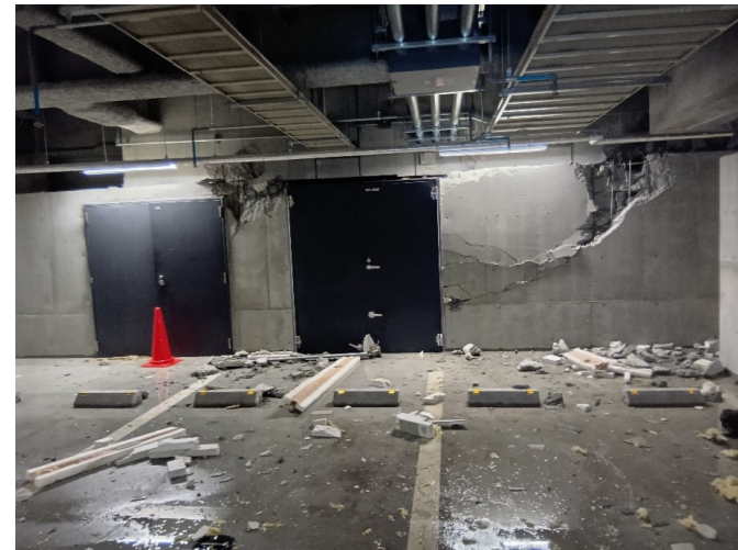
地下駐車場西側壁
