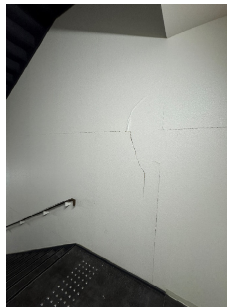
3階西側階段室
