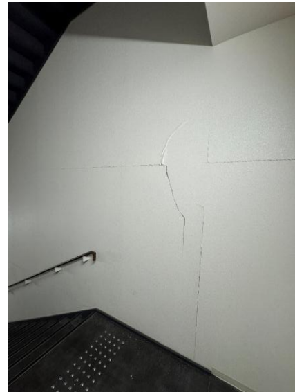
3階西側階段室
