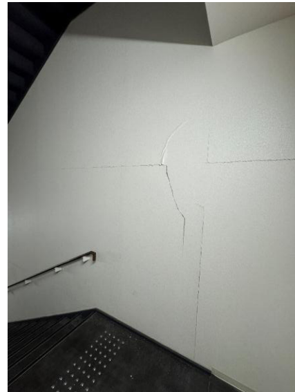
3階西側階段室
