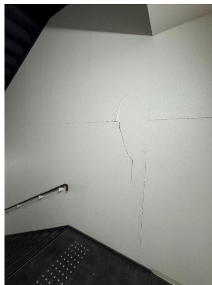
3階西側階段室
