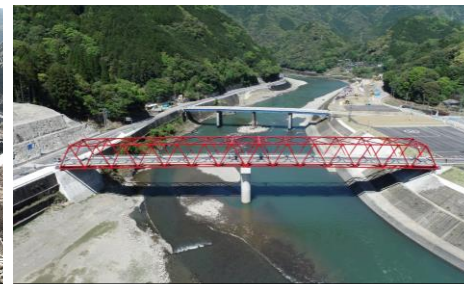
坂本橋（令和8年2月完成）
