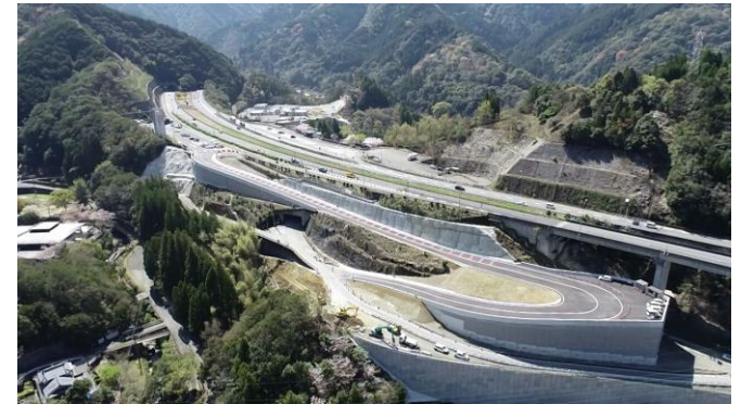
坂本PAへ接続するために整備された工事用道路下り線（R7.3月開通）
