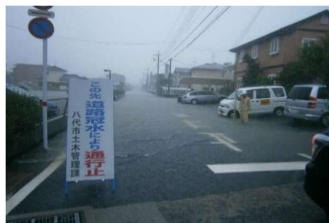
(八千把地区における道路冠水時の様子)
