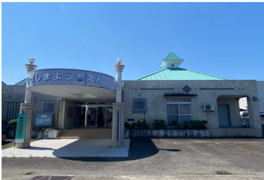
園舎（道路側より）
