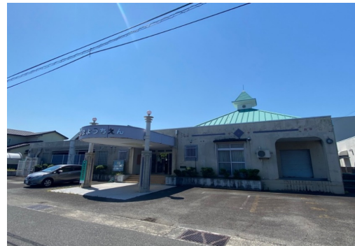
園舎（道路側より）
