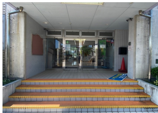
園舎正面玄関
