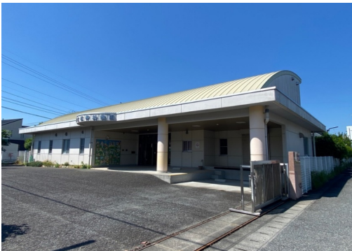
園舎（道路側より）
