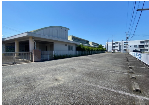
園舎（道路側より）
