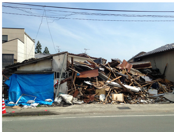
図 1.1.1 熊本地震の状況
