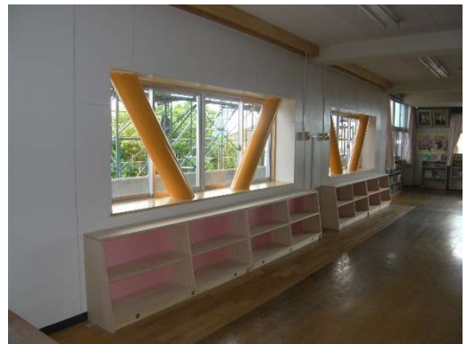
図 4.3.1 耐震改修状況
