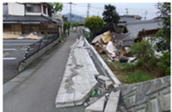
図 4.5.5 ブロック塀の倒壊(熊本大学減殺型社会システム実践研究センター)
