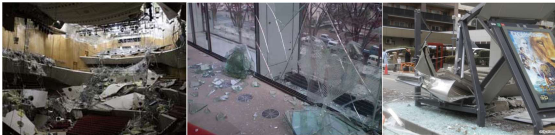
図 4.5.1 非構造部材の被害【天井・窓ガラス・外壁】 (写真：(左) 国土交通省、(中、右) 仙台市)
