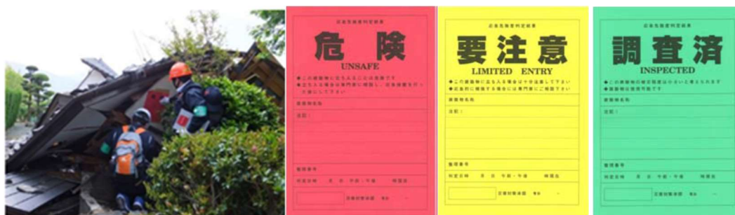
図 4.5.6 被災建築物応急危険度判定のイメージ（写真：独立行政法人建築研究所）
