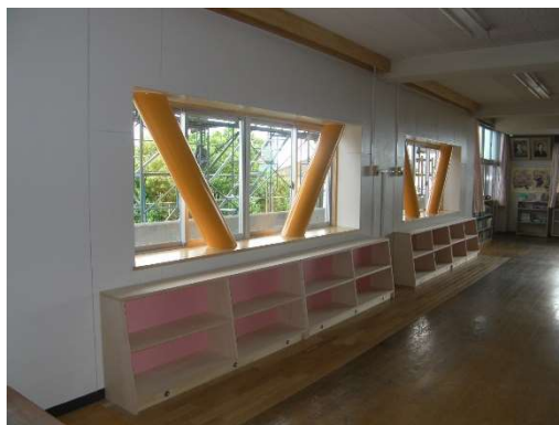
図 4.3.1 耐震改修状況
