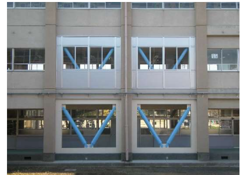
図 4.2.1 学校の耐震改修状況
