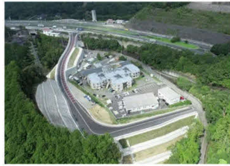
坂本PA(上り線)の工事用道路
