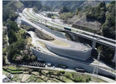
坂本PA(下り線)の工事用道路
