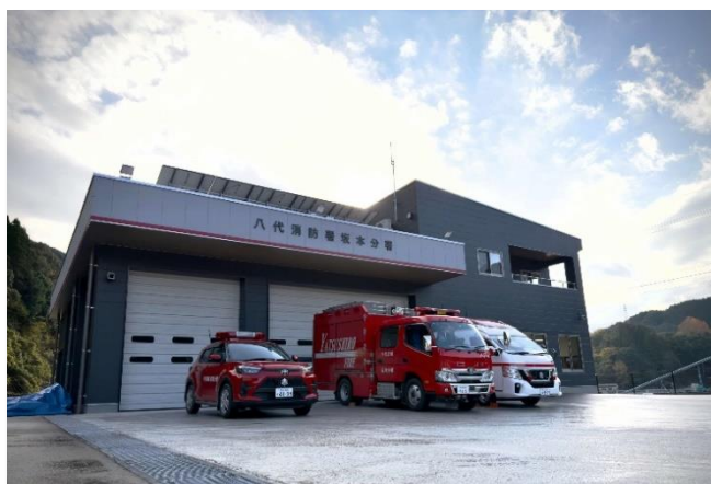
八代消防署坂本分署
