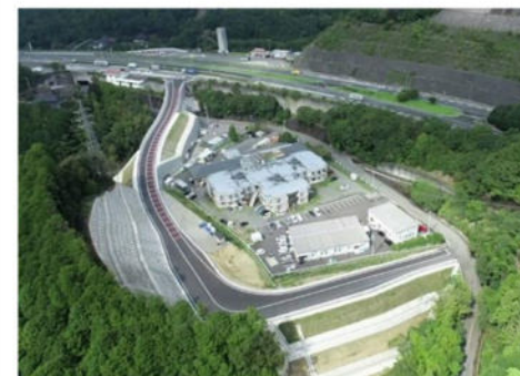
坂本PA(上り線)の工事用道路
