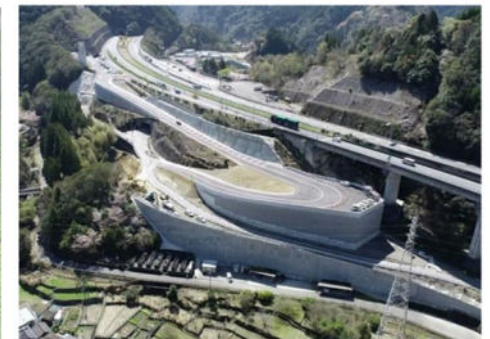
坂本PA(下り線)の工事用道路
