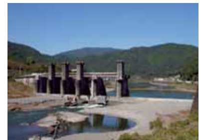
（撤去工事中の荒瀬ダム：坂本）
