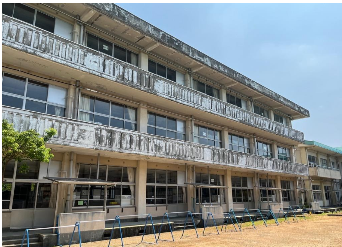
【松高小学校校舎の外壁劣化状況】
