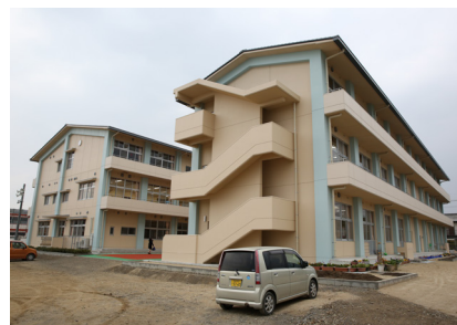
▲完成した新校舎
