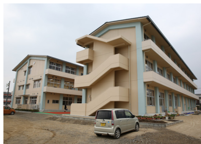
▲完成した新校舎
