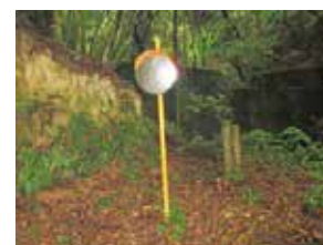
⑯砂防ダム及びカーブミラー
