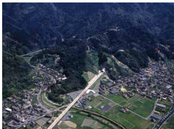
古麓城跡全景（北西側から）
