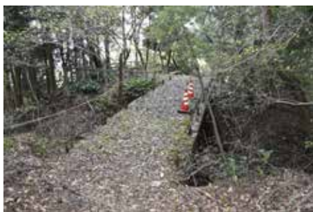
Photo.26 伝新城跡に架かる橋の現状（北より）
