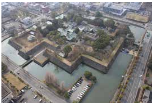
Photo.20 八代城跡全景（北東より）
