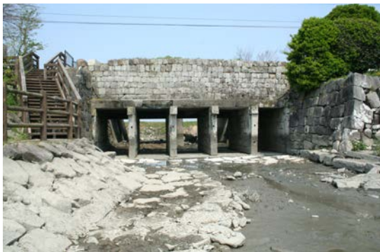
Photo.12 大鞘樋門群「殻樋」
