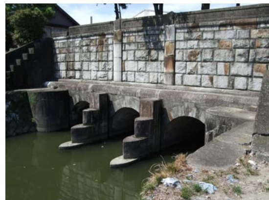
Photo.14 郡築二番町樋門
