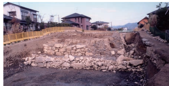
Photo.08 麦島城跡小天守石垣
