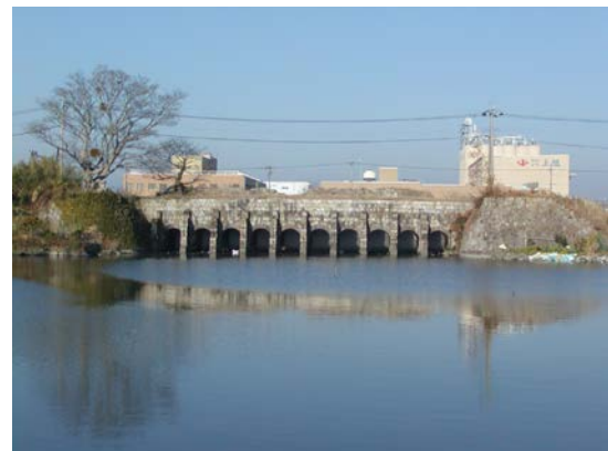
Photo.13 旧郡築新地甲号樋門
