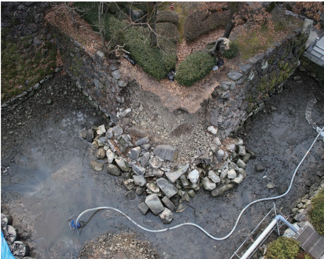
熊本地震で崩壊した八代城跡本丸廊下橋門跡東側石垣隅角部
