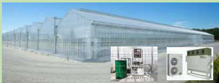
CO 2 貯留・供給装置 ヒートポンプ
