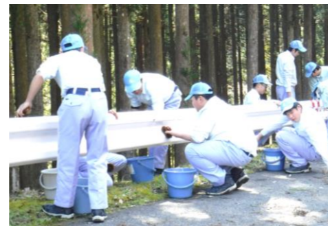
▲清掃作業の様子
