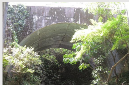
氷川支流土生谷川 下流側から撮影
