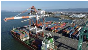
(八代港のガントリークレーン)
