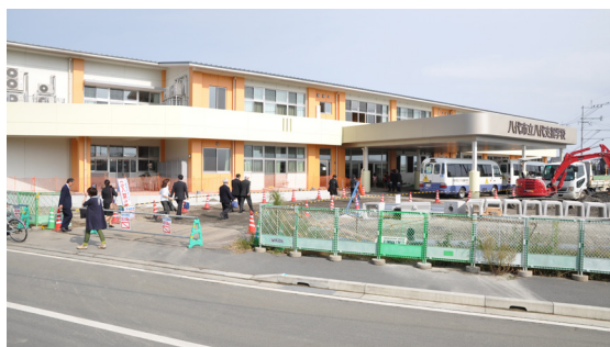
▲完成した新校舎。外構などは今年度中に完成予定
