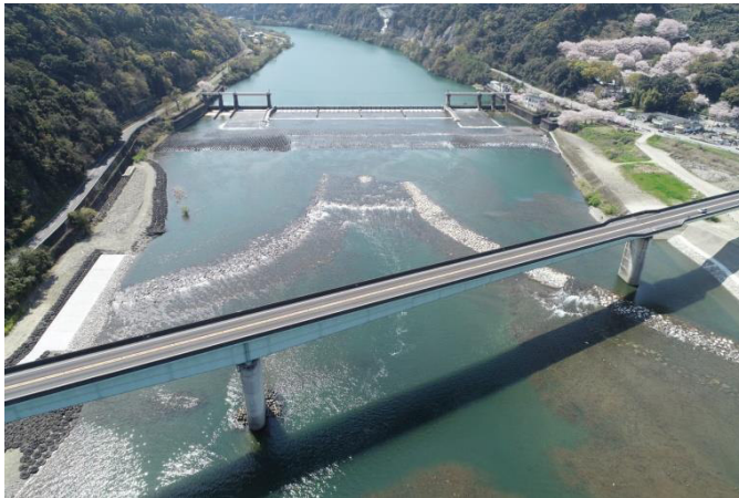
上空から見た「八の字堰」(平成31年3月完成)
