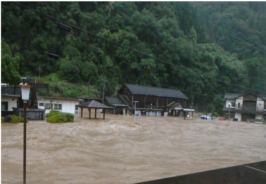
令和2年7月豪雨 JR 肥薩線坂本駅前
