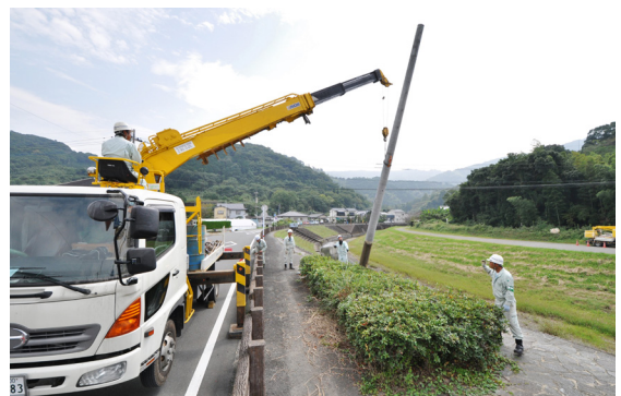
▲電線の地中化に伴う電柱の撤去作業 (10/2)
