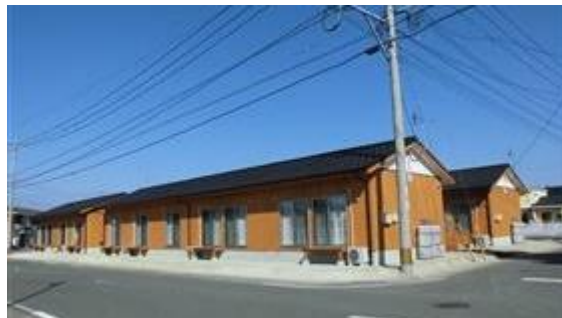
【八代市古閑中町仮設団地】
