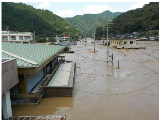
〔坂本支所付近〕
