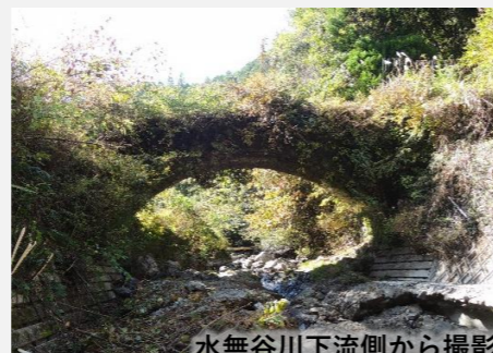
水無谷川下流側から撮影
