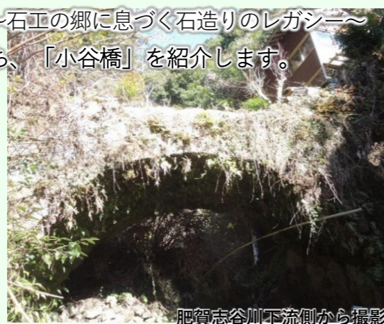
肥賀志谷川下流側から撮影
