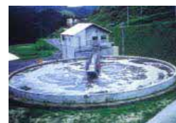
畜産環境対策施設
